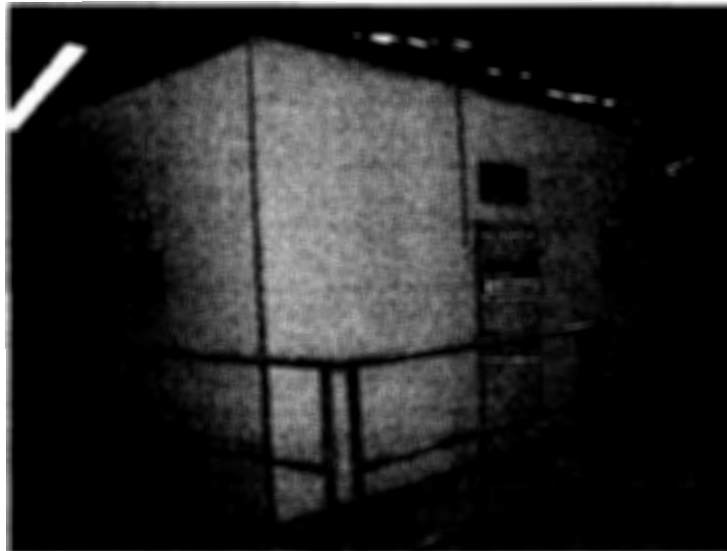
Gambar 2. Contoh ruang pendingin untuk Penyimpanan Limbah B3 berupa Limbah infeksius, benda tajam, dan/atau patologis dalam waktu lebih dari 48 (empat puluh delapan) jam sejak Limbah B3 dihasilkan.
